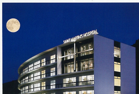
建物側面に十字架を配置。内側の上層階病棟はデイルームとなる
